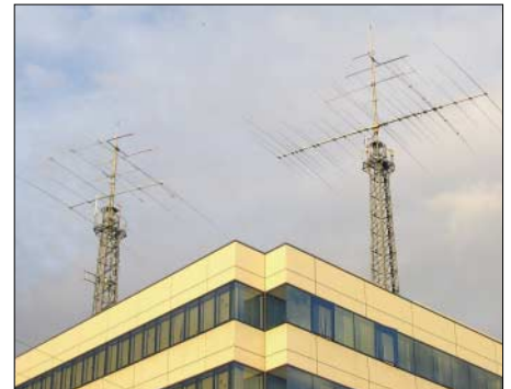
Imposante Antennenanlage auf dem ICOM-Hauptgebäude in Osaka
